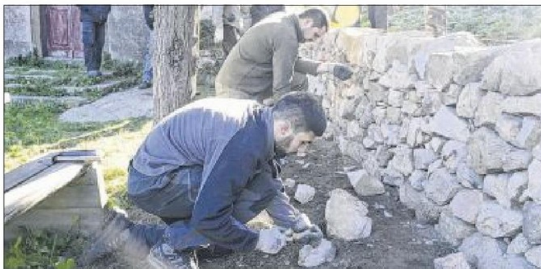
Une formation dédiée à la restauration d'ouvrage en pierre sèche a été organisée à Montegrosso par le Pays de Balagne. Il s'agit de la 7 e formation territorialisée proposée en Balagne. / PHOTO M.-S.-A.
